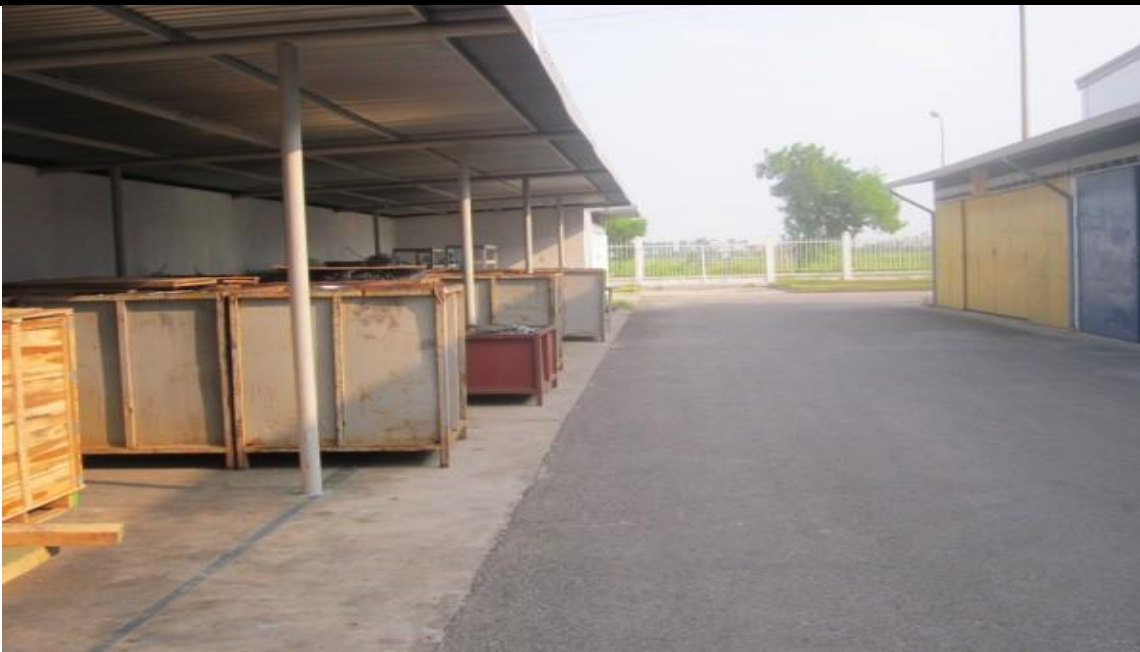
Hình 4-8: Hình ảnh kho rác thải phục vụ cho cả giai đoạn I & II đã được xây dựng tại Công ty TNHH Valqua Việt Nam
